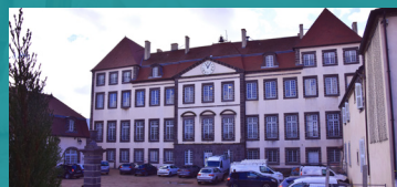
Antenne de Combronde 2
