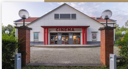
Culture Réhabilitation du cinéma intercommunal "La Viouze"
